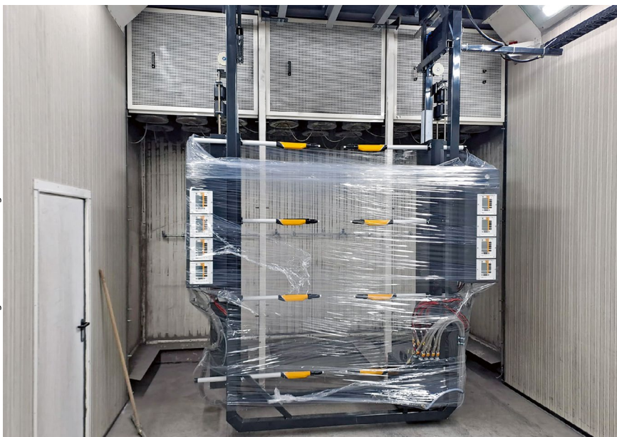
Der Beschichtungsautomat wurde als kompakte Einheit angeliefert und innerhalb von drei Tagen in die bestehende Pulverkabine integriert.
